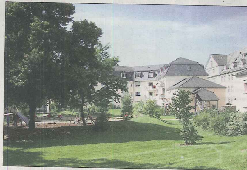
Trendwende. 1985 präsentierte sich ein Wohnhaus in der Ambrosiusstraße in einem desaströsen Zustand (Bild oben). Der Abriss und Neubau der Anlage durch die Wogebe vor zehn Jahren brachte große Fortschritte. Fotos: Wogebe
