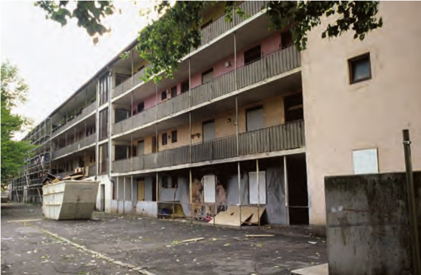
2000: Ambrosiusstraße vor Abriss
