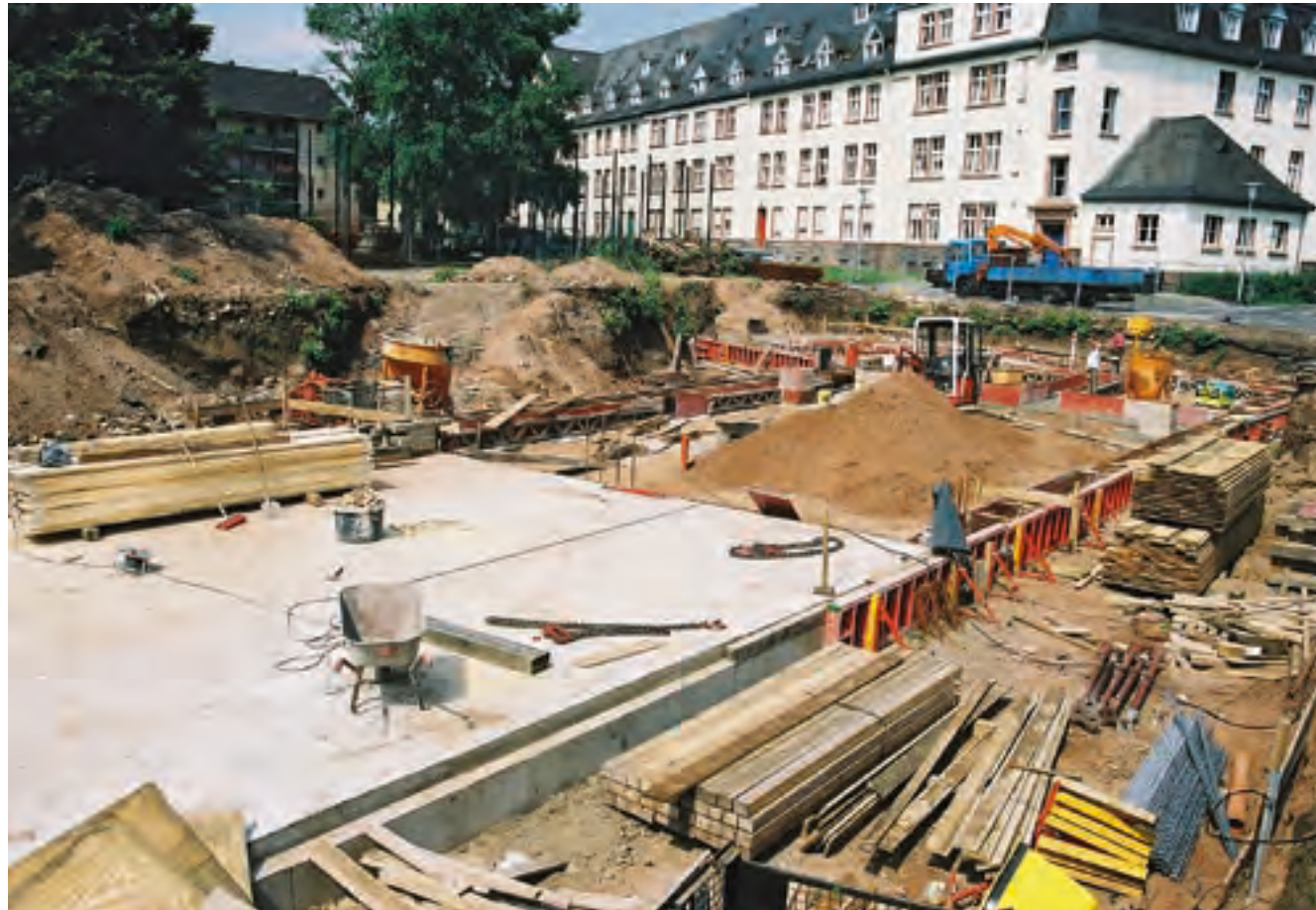
2001: Ringsiedlung im Bau
