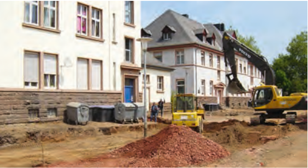
2004: Ausbau der Straße Am Beutelweg
