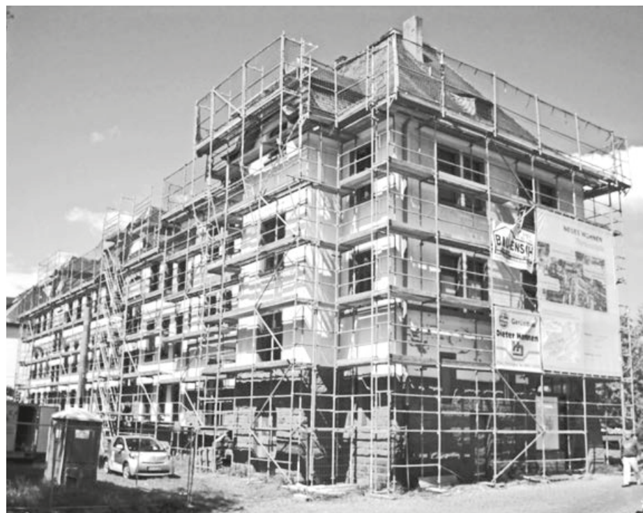
Sanierung Thyrsusstraße 27-31 (Gartenseite); Foto: WOGEBE
